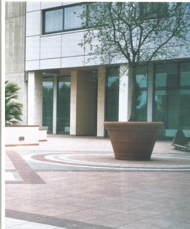
Foto 9 e 10. Alcuni momenti della posa delle piastrelle nel cortile e nel giardino interno. In questi spazi è stato utilizzato il gres porcellanato per ambienti esterni posato con KERAFLEX® mentre per la stuccatura delle fughe è stato preferito KERACOLOR GG.
